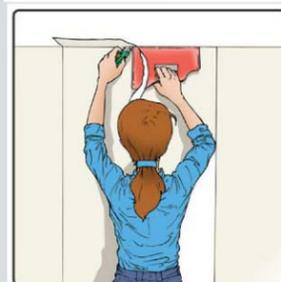
Découper les lés à la longueur voulue (+ 5 cms pour les arasements). Ensuite, encoller suffisamment et régulièrement le support au rouleau à poils 12 mm, sur une largeur de un lé (+/-300 gr/M2).
